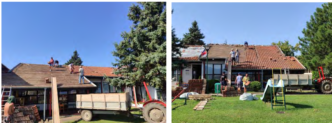
Слика 43. Радови на замени кровне конструкције
